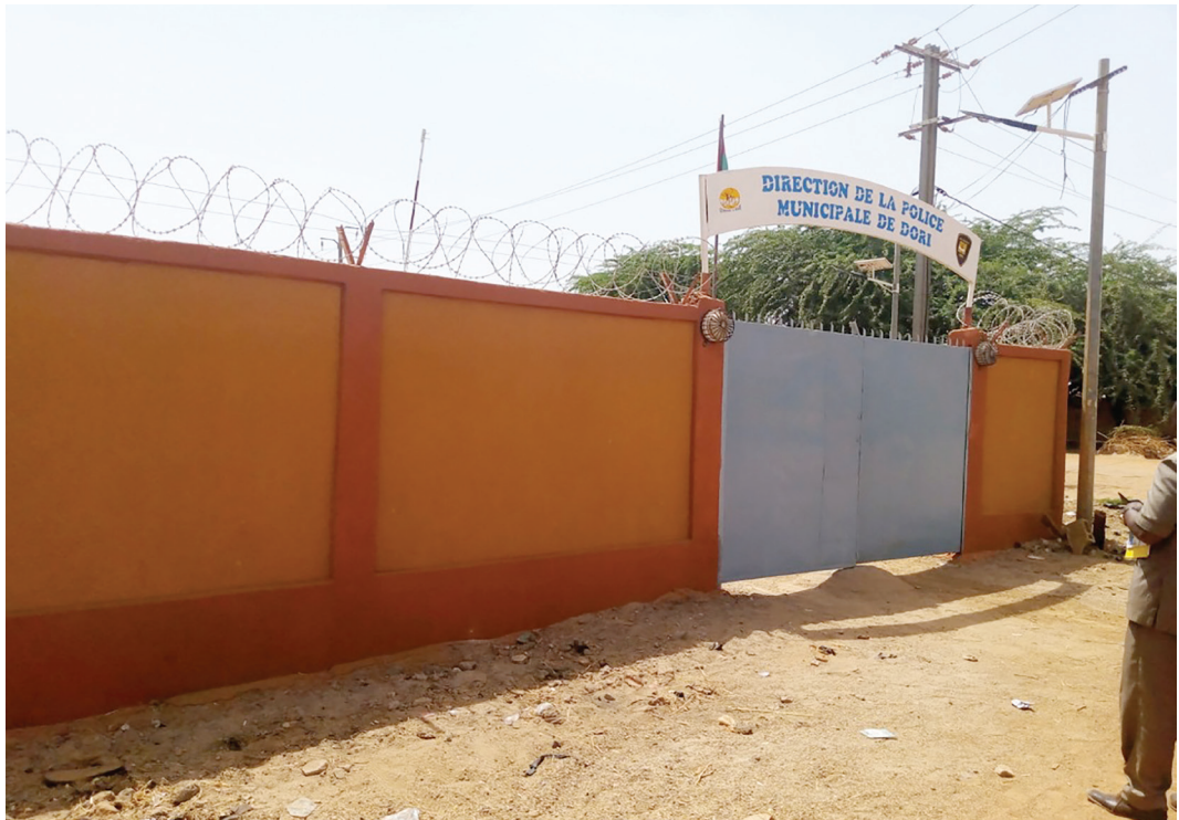
Construction d'un mur de clôture du poste de police Municipale de Dori, 2020
