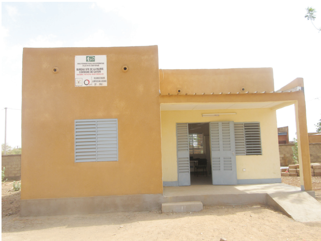
Construction d'un Bâtiment SFR à la mairie de Gayéri
