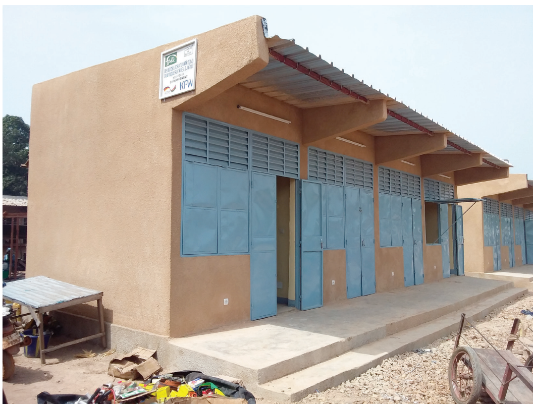
Construction de huit (08) boutiques de rue à Djigouè dans la commune de Djigouè
