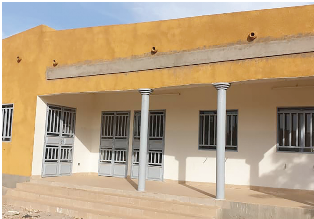
Construction d'un bâtiment administratif annexe, du mur de clôture et d'une guérite à la Mairie de Boundoré
