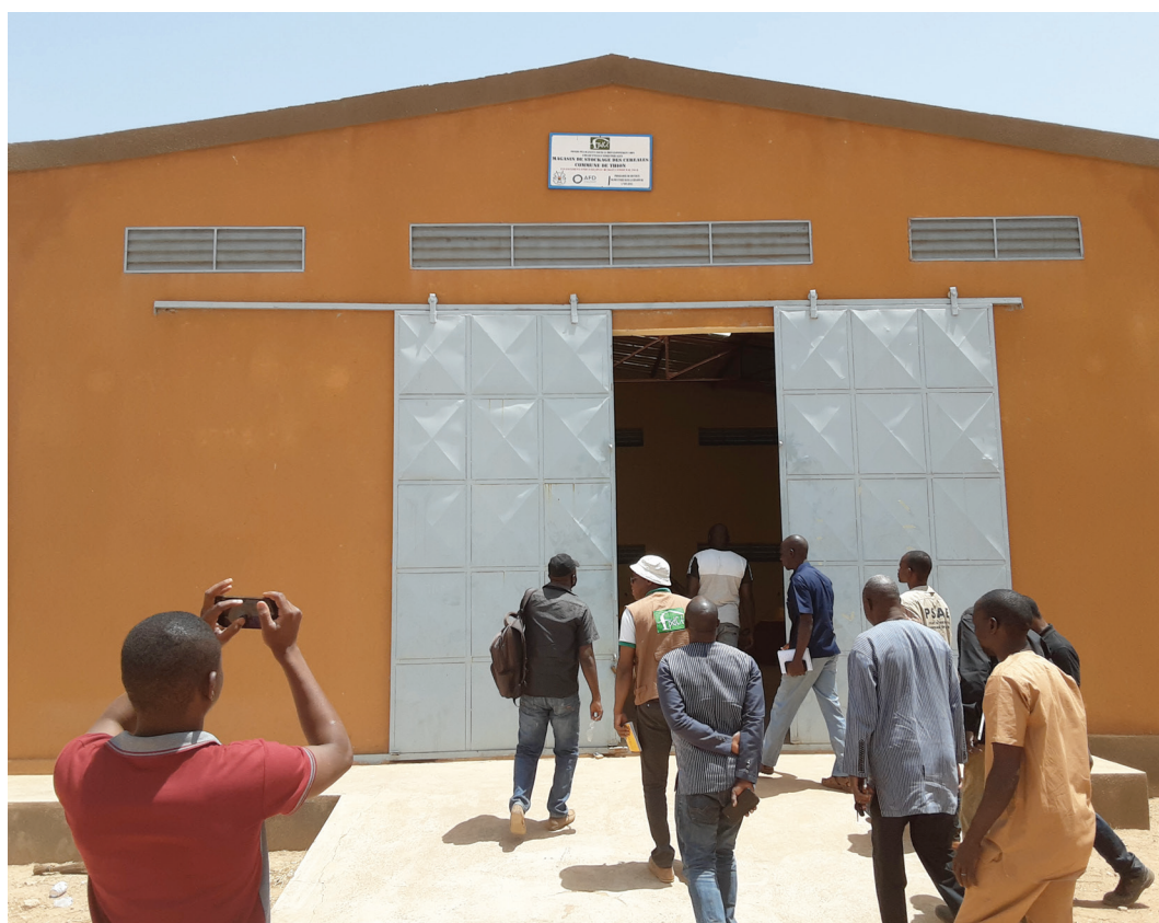
Commune de Piéla - Construction d'un magasin de stockage de 50T
