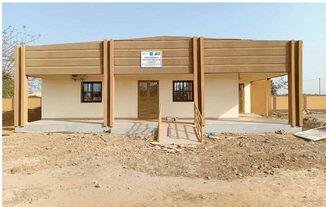
Bâtiment administratif du centre de santé communautaire de Ouahigouya
