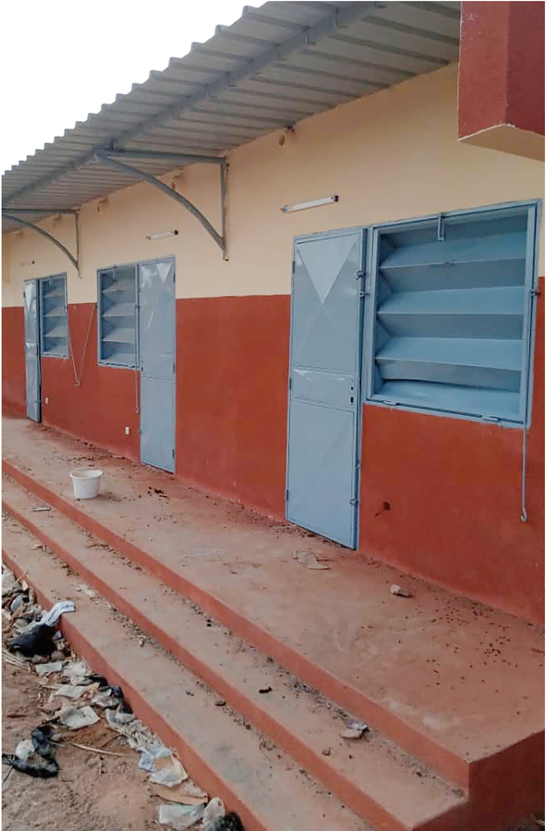
Construction de quatorze (14) boutiques au marché central de Déou
