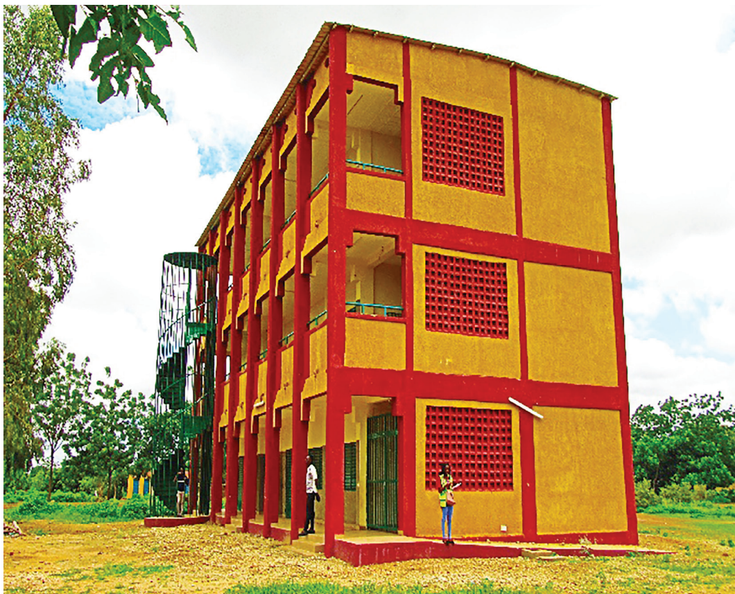
Construction d'un CEG R+2+(01) bâtiment administratif+ latrines à Ouidtenga au secteur 49 dans l'arrondissement 11 de la commune de Ouagadougou
