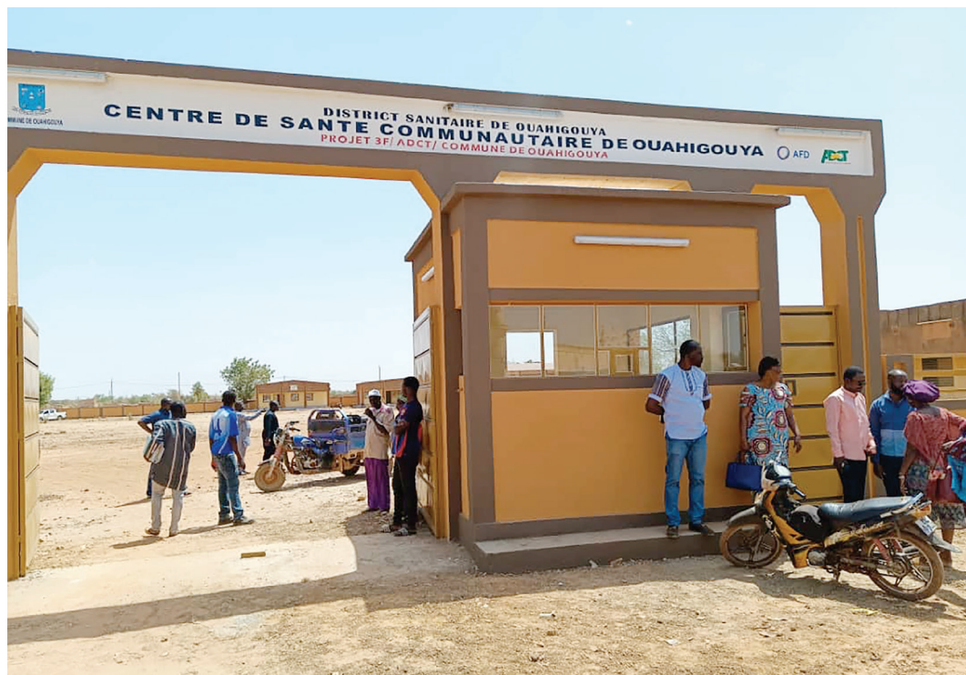
Mur de clôture du Centre de santé communautaire de Ouahigouya
