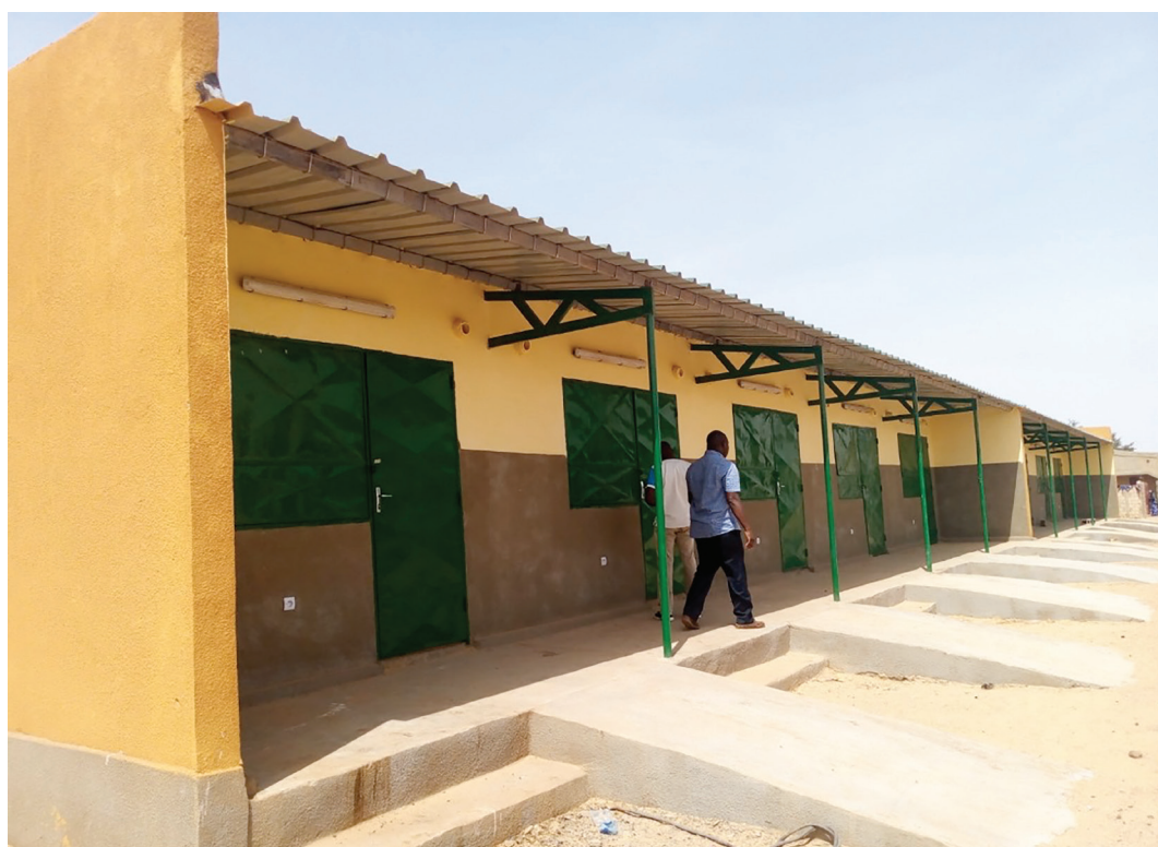
Construction d'un marché moderne à Wendou, Dori
