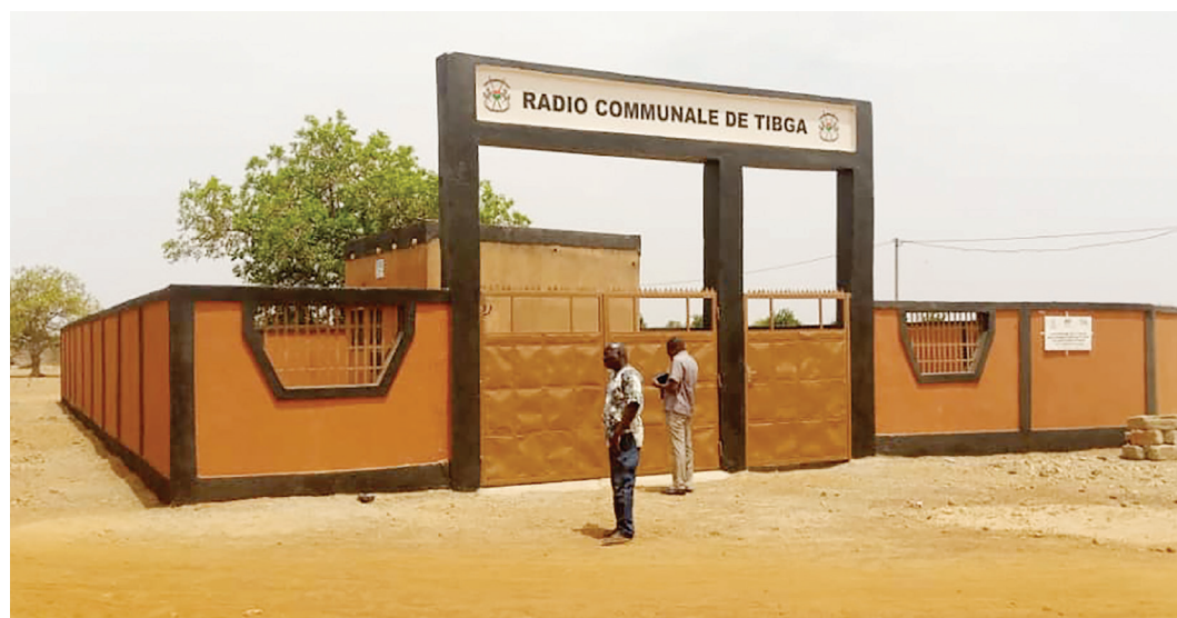
Construction du mur de la radio rurale de Tibga
