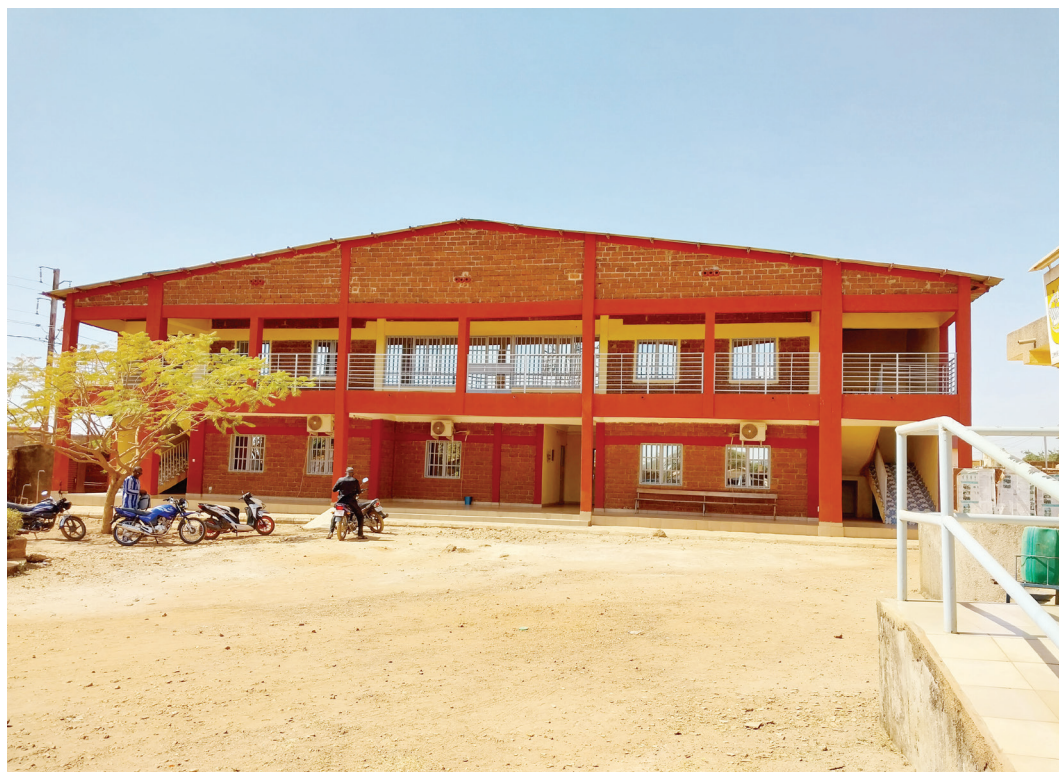
Contribution à la construction d'un bâtiment administratif de niveau R+1 à la mairie de Diébougou dans la commune de Diébougou
