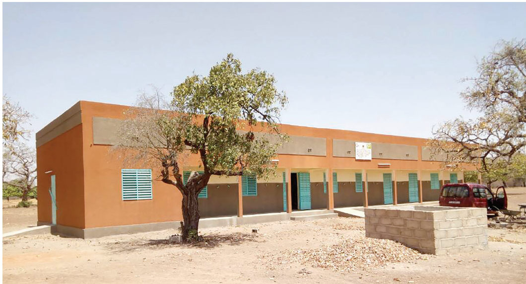
Construction de trois (03) salles de classes équipées, un bureau, un magasin et un bloc de latrine à quatre (04) postes à Koendé dans la commune de Andemtenga
